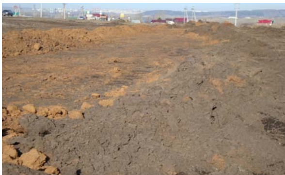
Рисунок 1. Уничтожение плодородного слоя почвы при проведении работ по строительству газопровода вблизи д. Дорогино Уфимского района ООО «Уфаспецстрой» [27, 28]
